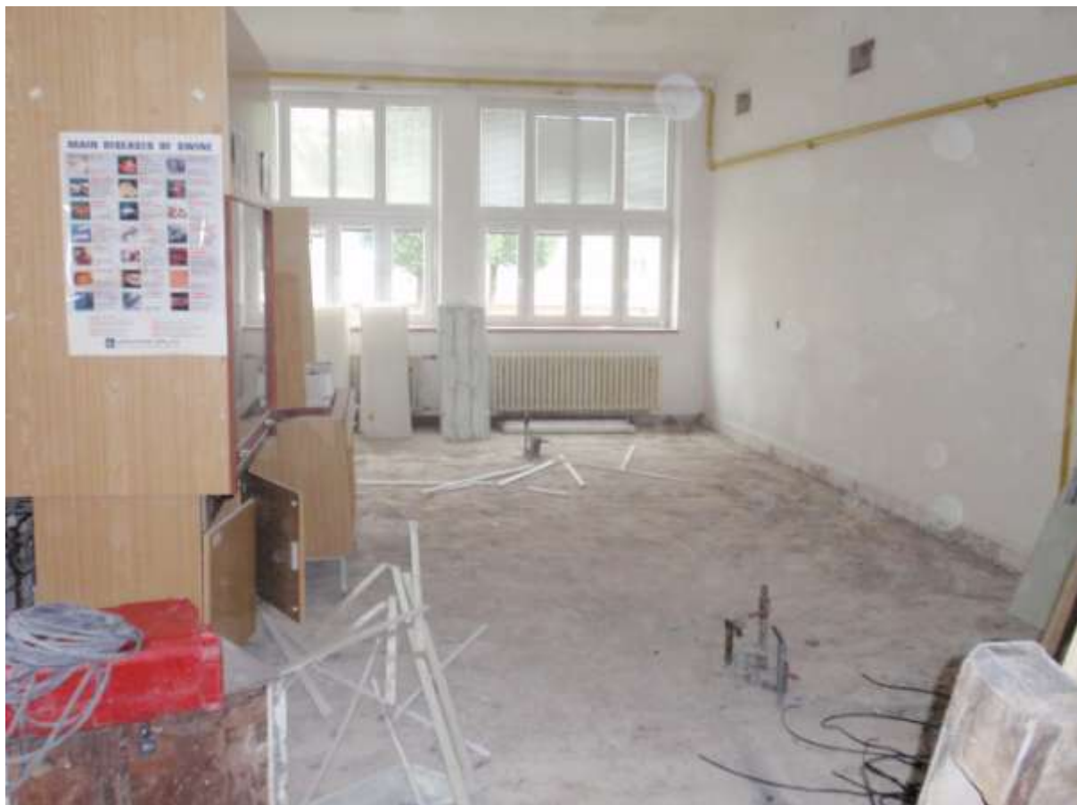
Fotodokumentace z vlastní realizace rekonstrukce laboratoří
